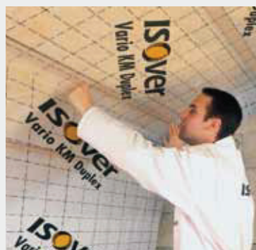
Fig. 4 Breng een lucht/dampscherm aan, zoals Isover vario KM duplex. Appelez un pare-vent/vapeur, comme l'Isover vario KM duplex.
